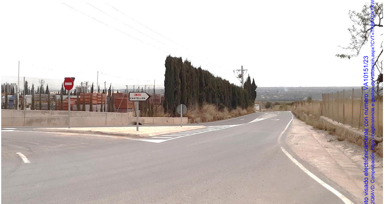
Imagen el Vallado perimetral, linde sur con pantalla vegetal existente
